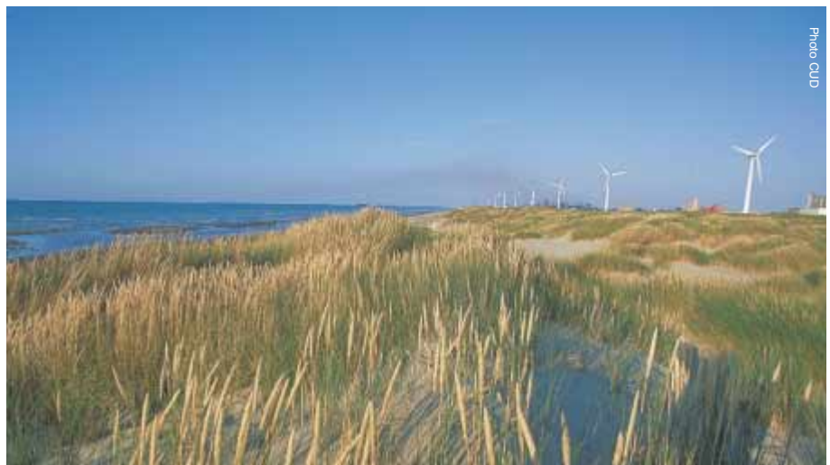
Dunkerque : la centrale éolienne
