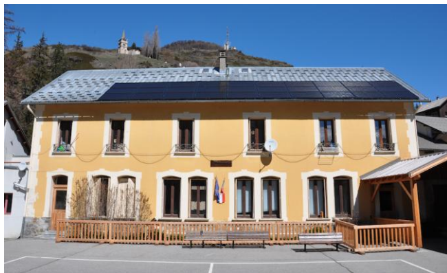
Récente installation photovoltaïque sur l'école d'Abriès en PACA qui sera inaugurée le 4 juin 2016 © Centrales Villageoises Ener'Guil
